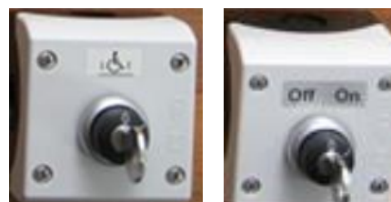
3. att. Vadības centrs ar atslēgu
