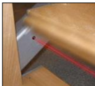
I sensori a infrarossi evitano lo schiacciamento tra i gradini.
