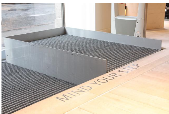
HDN-tasonostin käyttövalmiina ylätasolla
