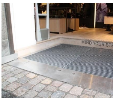
Plancher plat, prêt pour entrer/sortir
