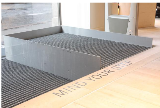
HDN-lift klaar voor gebruik op het bovenste niveau
