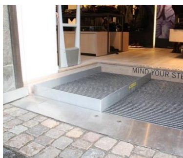
Sikringsplater kjørt opp
