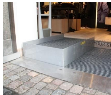
Lift uppe, klar för på-/avkörning.
