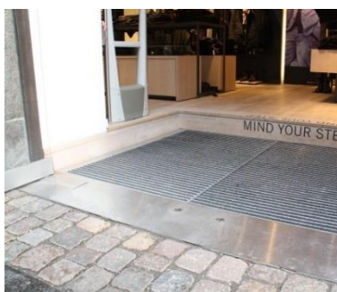
Plant gulv, klar til på-/afkørsel
