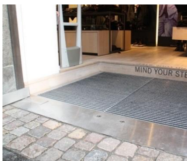
Livello pavimento, pronto per l'accesso/uscita
