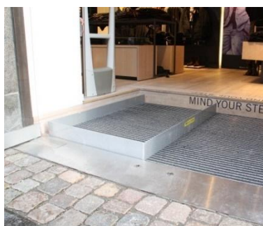
Sikringsplater kjørt opp
