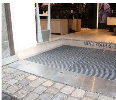
Plant golv, klar til på-/avkjørsel
